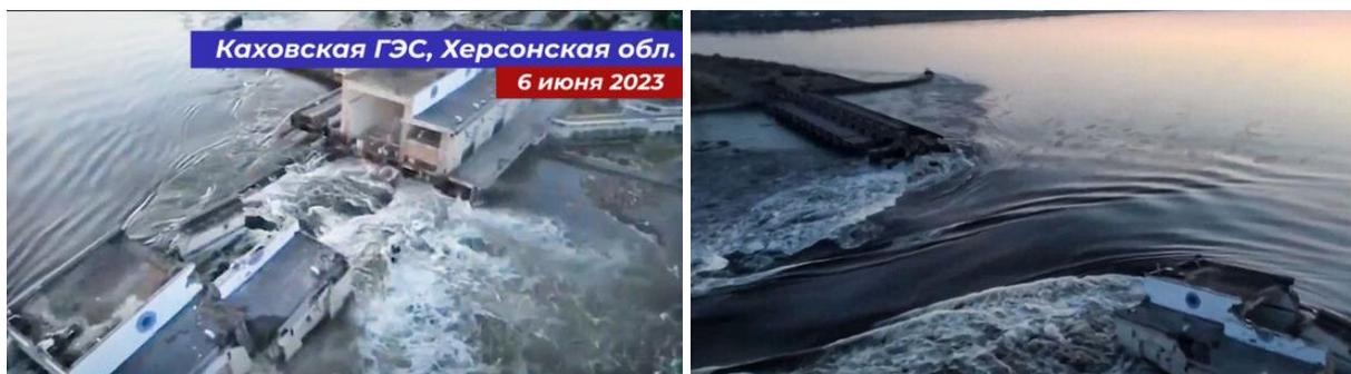
On voit que, au niveau de l'usine, la rupture n'affecte que la partie supérieure de l'infrastructure ; alors que, au niveau de la brèche dans l'évacuateur de crues, l'écoulement est manifestement très rapide, autrement dit avec une hauteur libre assez importante. Il est également notable qu'aucune des piles de l'évacuateur ne fait obstacle à l'écoulement.
